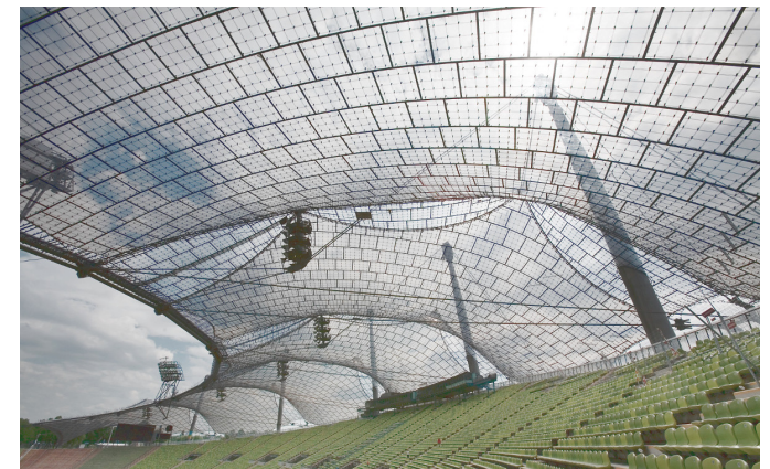
Das Zeldach des Olympiastadions in München ist eine Minimalfläche. Es beruht auf Ideen von Frei Paul Otto (1925–2015) vom Institut für Leichte Flächentragwerke der Universität Stuttgart.
