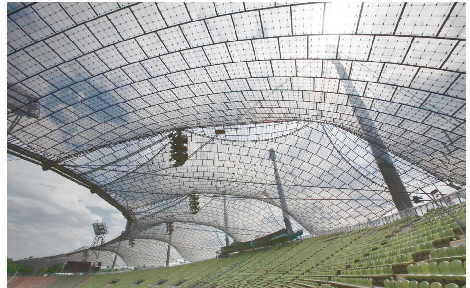
Das Zeltdach des Olympiastadions in München ist eine Minimalfläche. Es beruht auf Ideen von Frei Paul Otto (1925–2015) vom Institut für Leichte Flächentragwerke der Universität Stuttgart.
