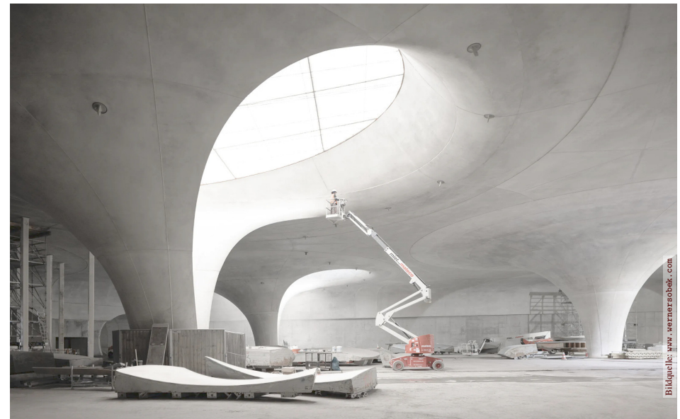
Ein halbes Jahrhundert später werden solche Konstruktionen auf dem Computer berechnet: Von der Seifenblase zur Kelchstütze, nach Ideen von Frei Otto. youtu.be/_Lp6bdxFPu
