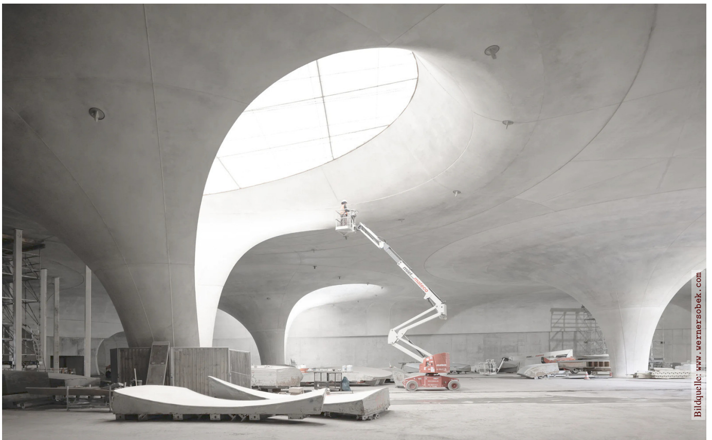
Ein halbes Jahrhundert später werden solche Konstruktionen auf dem Computer berechnet: Von der Seifenblase zur Kelchstütze, nach Ideen von Frei Otto. youtu.be/_LpP6bdxFPU
